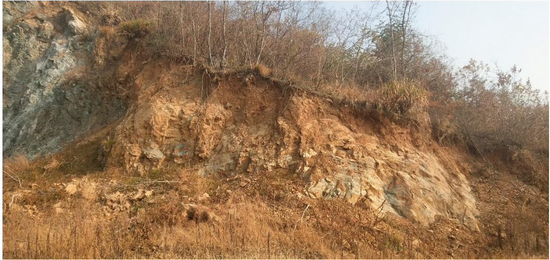
5-13 宕口东侧边坡坡面浮土
