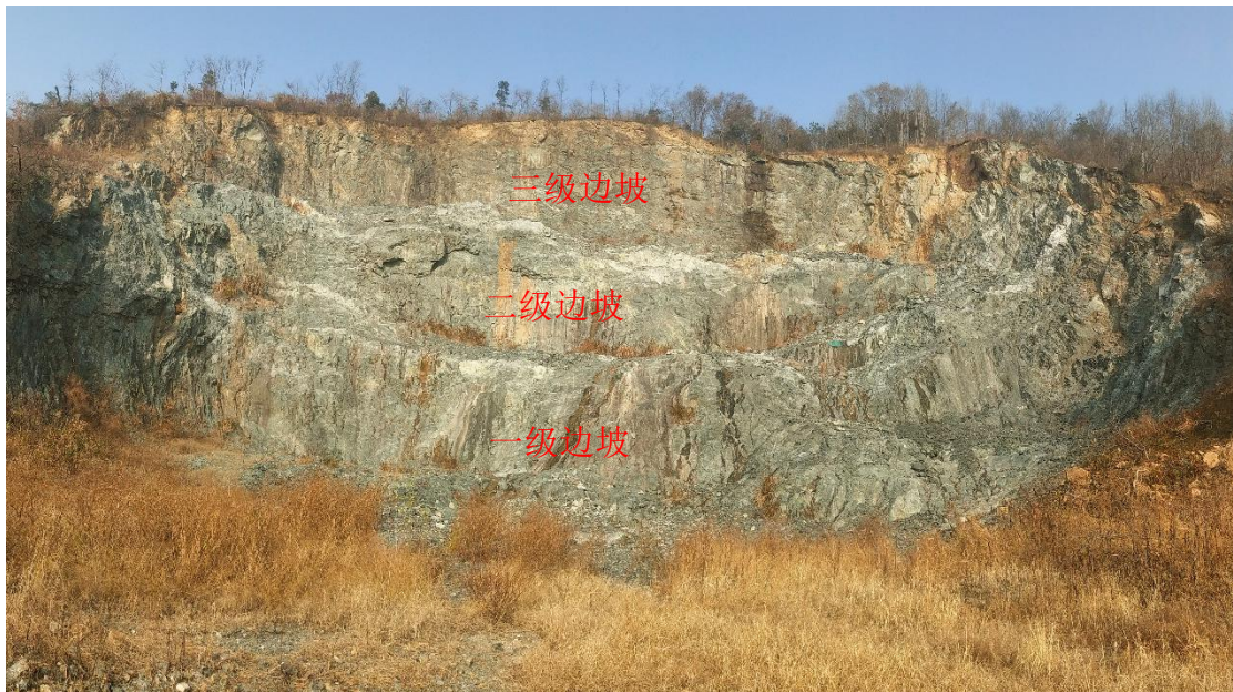
照片5-2 北段边坡全景
