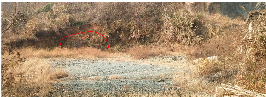
照片 5-8 底盘边坡全景（红色区域小型崩塌）
