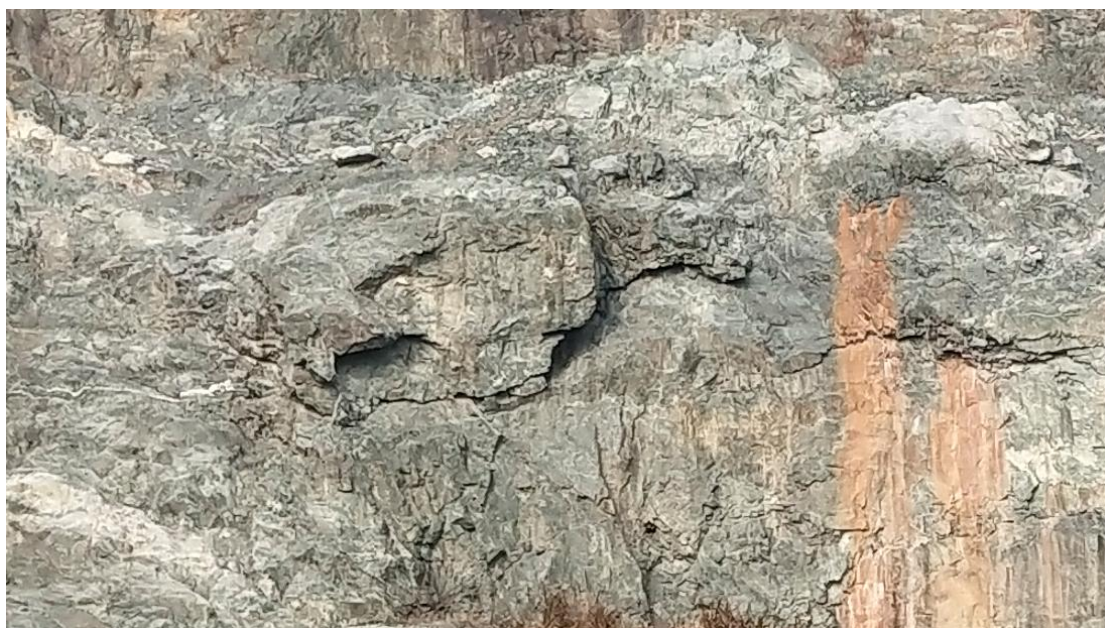
照片 5-4 W2 边坡危岩体（裂隙面张开状）
